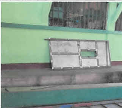
FOTO 3: SUSTITUCION DE PUERTAS DE AULAS
