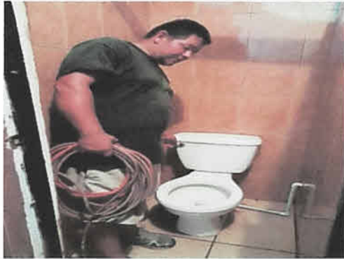
FOTO 1: REPARACION DE SANITARIOS
