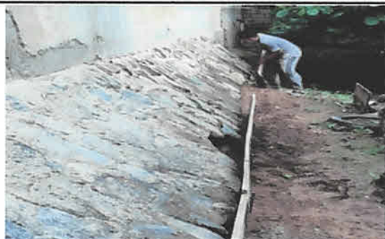
FOTO 5. REPARACION MURO DE CONTENCIÓN
