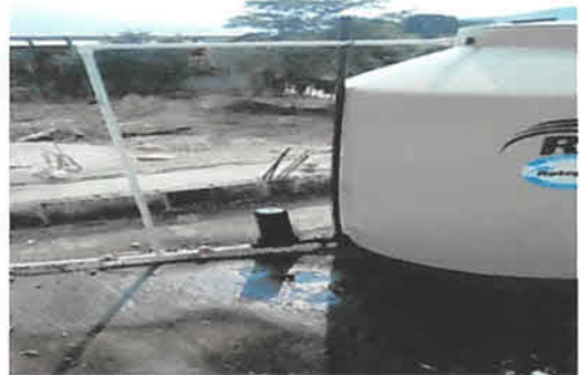
FOTO 4: INSTALACION DE TINACO
