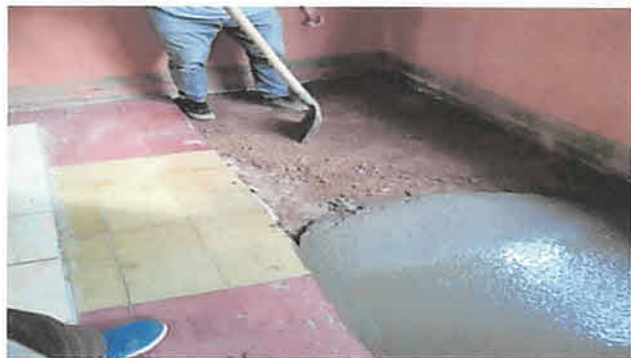
FOTO 1: COMPACTACION DEL SUELO DE AULA
