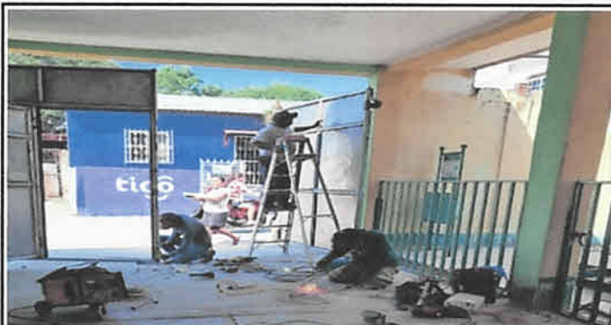
FOTO 3: SUSTITUCION DE PORTON PRINCIPAL
