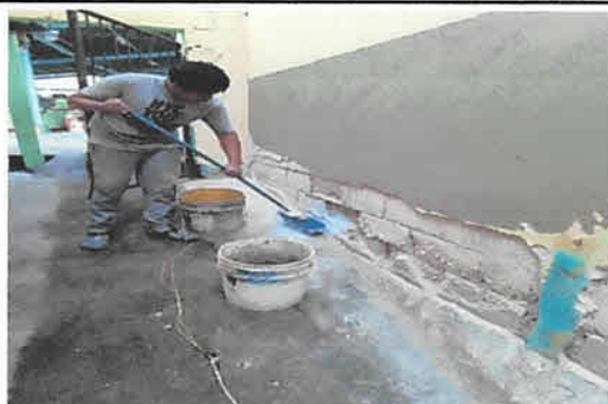
FOTO 4: REALIZANDO LA IMPERMEABILIZACION EM PARED EXTERIOR
