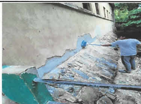
FOTO: REZANADO DE PARED EXTERIOR,
