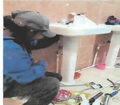
FOTO 2: REPARACION DE LAVAMANOS
